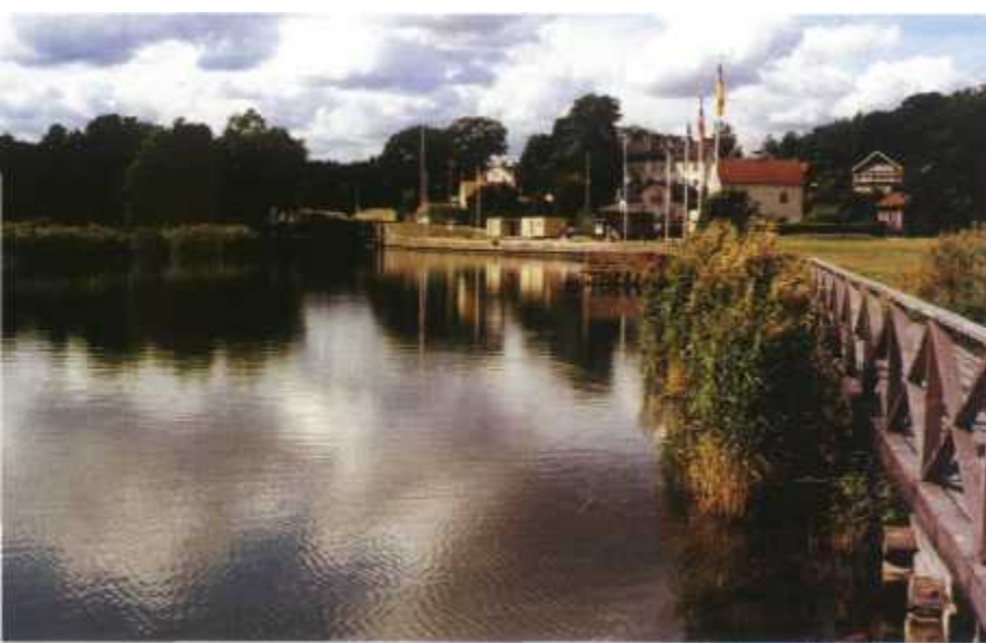
Mem - wejście do kanału od strony Bałtyku
